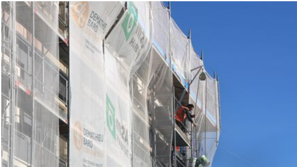
Un chantier de rénovation énergétique, à Mulhouse, en décembre 2025. (VINCENT VOEGLIN / MAXPPP)
